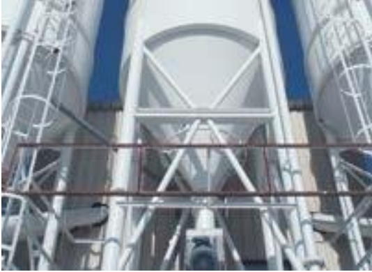
Şekil 1: Kireçtaşı oluşumu, kireç söndürücülerde ortak bir problemdir. Omya Neutrasorb tortu oluşturmaz ve bakım maliyetini düşürür.
